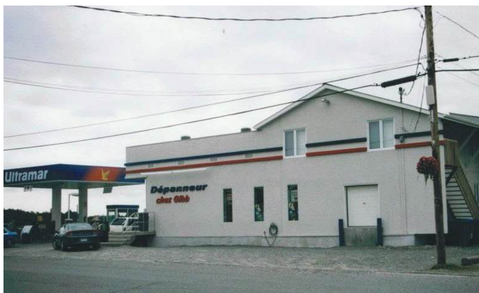
EN 2004, JACQUES ET LAURETTE ENTREPRENNENT D'IMPORTANTS TRAVAUX DE MODERNISATION DU COMMERCE.
