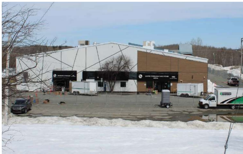
UNE JOURNÉE A ÉTÉ ACCORDÉE À LA RÉCUPÉRATION DE MATÉRIEL DANS LA PARTIE SUD DU CENTRE COMMUNAUTAIRE
